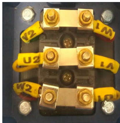
Соединение обмоток мотора по схеме «треугольник»
